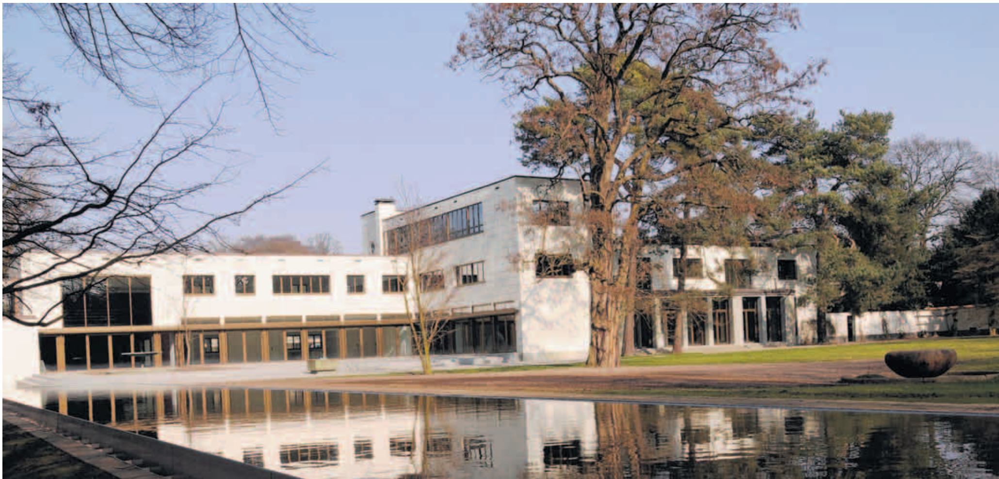
In dieser Villa wohnte bis 1945 der Zigarettenfabrikant Philipp F. Reemtsma. Nach seinem Auszug wurde das exklusive Anwesen zu einem Verwaltungsgebäude umgebaut. In akribischer Kleinarbeit brachten Restauratoren Altes wieder zum Vorschein, so die roten Kacheln im alten Schwimmbad, das zuletzt als Kantine diente. Jetzt wartet die Immobilie auf einen neuen Nutzer. FOTOS: ASTRID OTT
